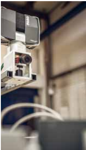
Kameras überwachen die Rückbauarbeiten
