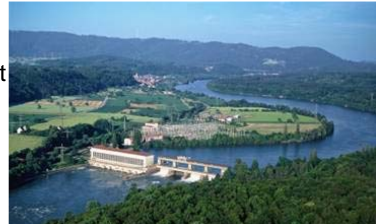
Flusskraftwerk KRS mit 120 MW größtes Hochrheinkraftwerk
