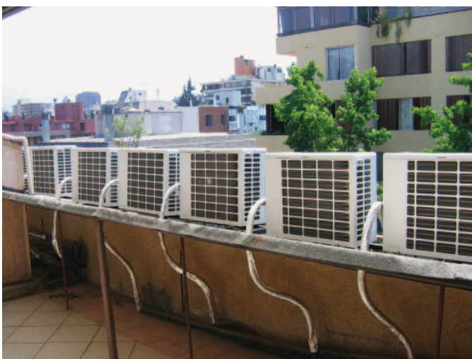
Eine Reihe von Außenmodulen dezentraler Klimaanlage in der Stadt.
