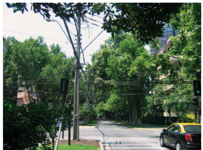
Oberirdische Stromleitungen: Rund die Hälfte des Stroms in der Region wird mit Wasserkraft erzeugt.
